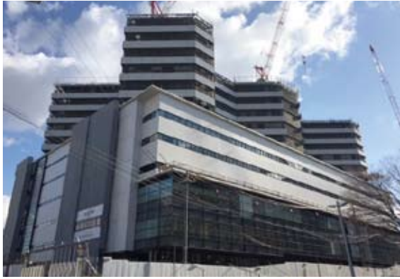
▲府庁南側で移転新築工事が進む府立成人病センター
